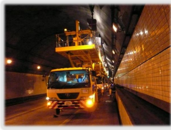
トンネル照明設備の施工 首都高速道路新路線の施工❖
