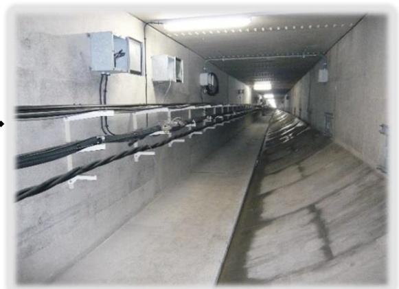
トンネル監査廊 監査廊内の電気設備、通信設備の施工❖
