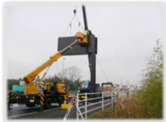
❖ 通信管路・通信線路・CATV工事施工 道路情報板の施工
