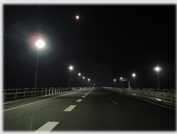
❖ 高速道路照明 照明設備、通信設備の施工
