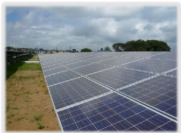
太陽光発電設備の施工 メガソーラー発電設備の施工❖
